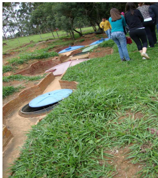
Alunos conhecem a fossa séptica do hotel, uma alternativa para o tratamento dos dejetos.
